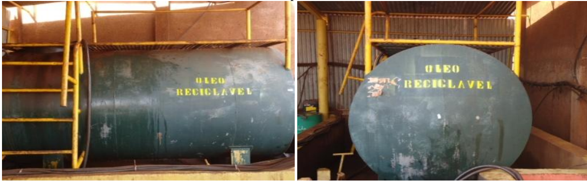
FIGURA 5 – Depósito Óleo contaminado
