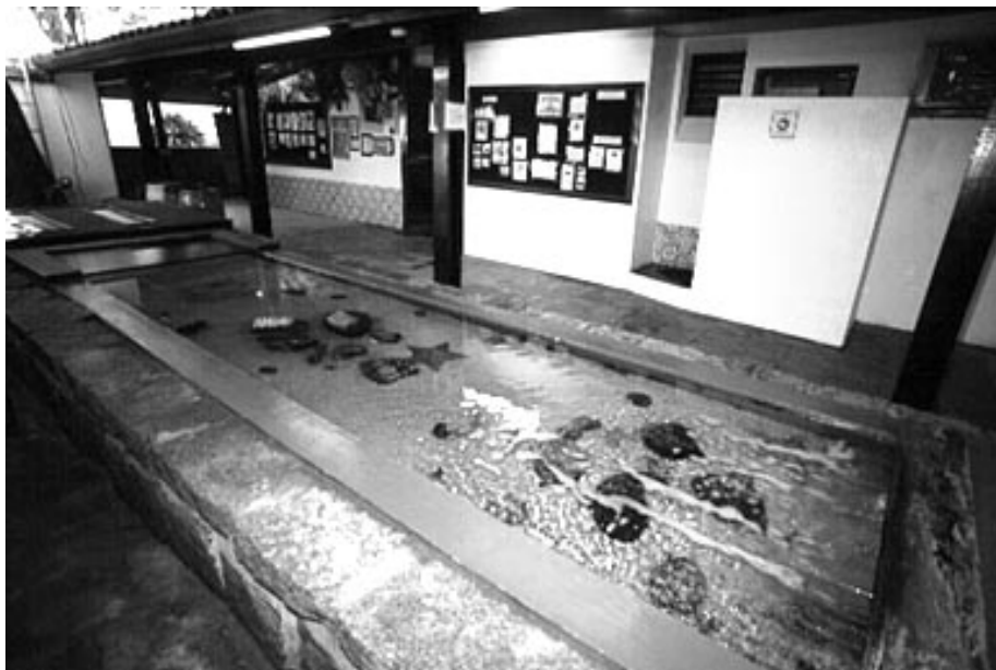
Figura 3: Tanque de contato
