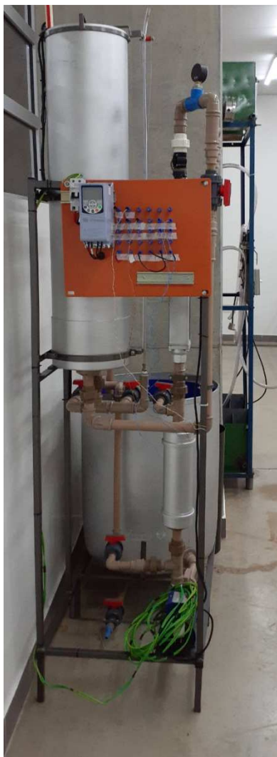
Figura 5. Inversor de frequência Weg CFW500 instalado na placa de montagem .
